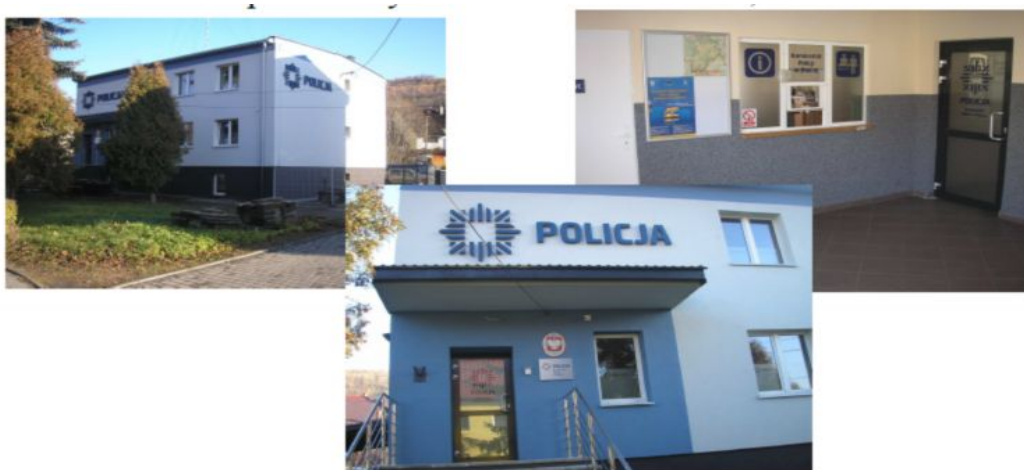
Zdjęcie nr 2. Komisariat Policji w Rajczy po przeprowadzonym remoncie
