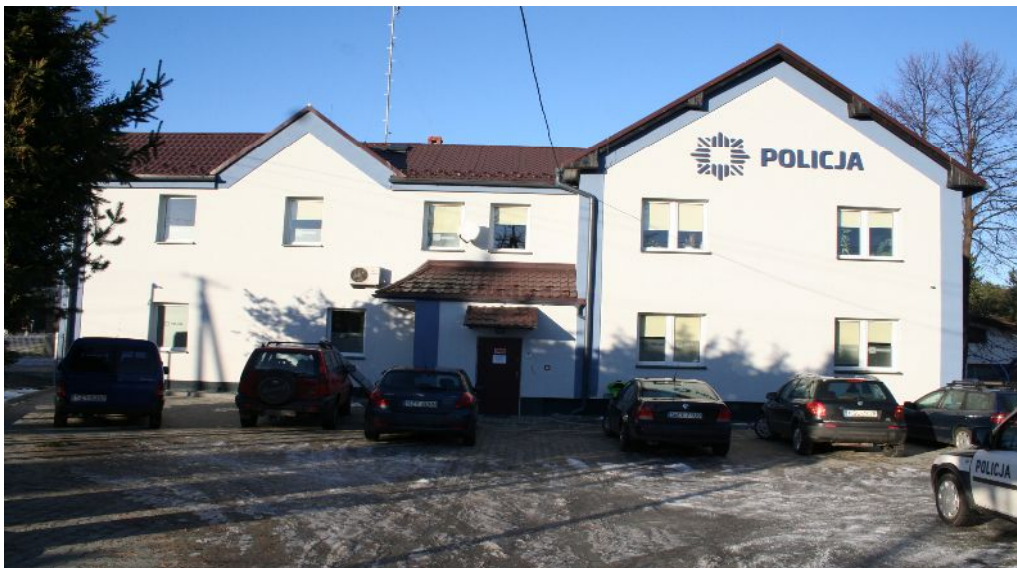
Zdjęcie nr 3. Komisariat Policji w Jeleśni po przeprowadzonym remoncie
